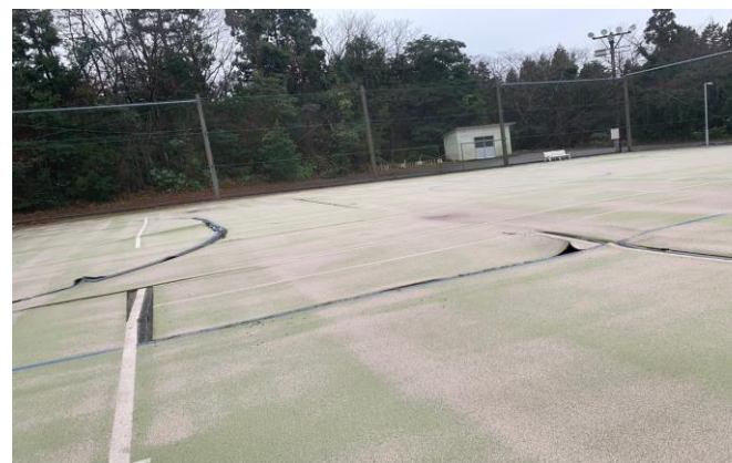
写真④ ⑤ フットサル&テニスコート亀裂・陥没
