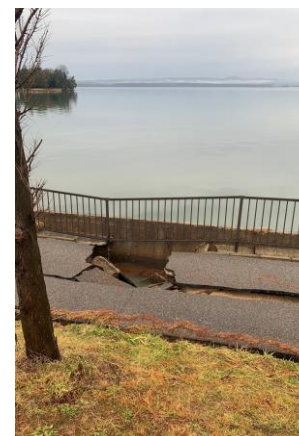
写真⑤ ⑥ 周囲ランニングコース 陥没・隆起
