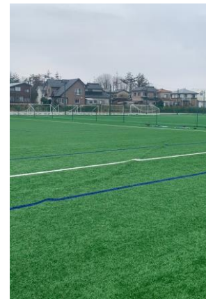
写真③ サッカーコートC隆起
