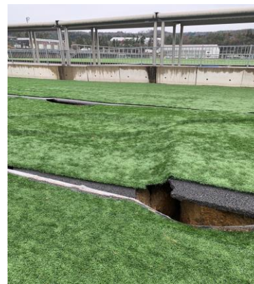
写真④ ⑤ フットサル&テニスコート亀裂・陥没
